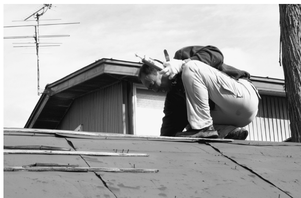
住宅改修ボランティア
